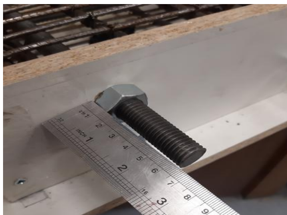
Figura 175: Sección sobresaliente de perno de anclaje.
