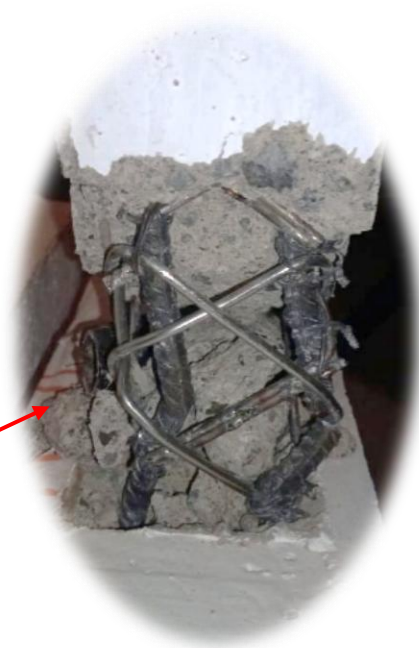
Fractura de Barra longitudinal en lado negativo de la viga, 4° ciclo de [30 mm].
