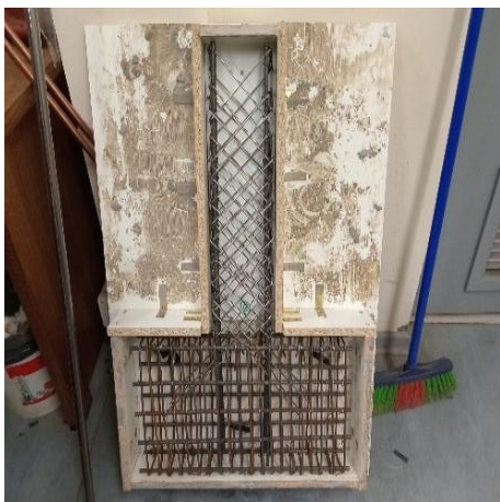
Figura 174: Colocación Armadura en moldaje.
