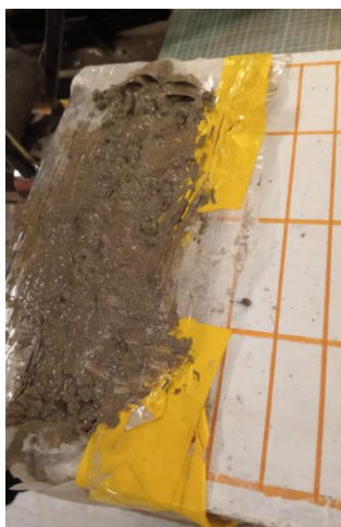
Figura 187: Colocación de Mortero nivelante.
