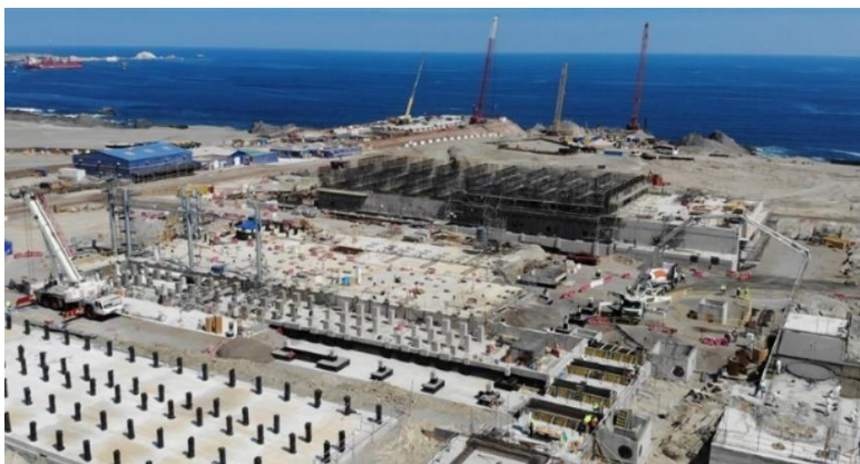
Ilustración 1.- construcción de planta desaladora de Compañía Minera Teck Quebrada Blanca
