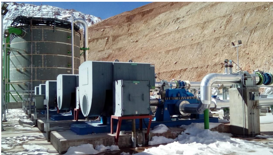
Ilustración 15: Configuración bombas PP071 a PP075
