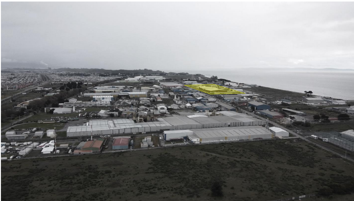
Fotografía 1-2. Vista Norte-Sur del Parque Industrial Coronel (planta ITI en amarillo)
