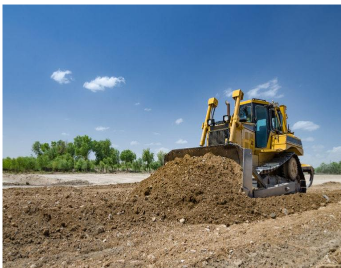
Figura 2-1 Preparación del terreno con el bulldozer.
