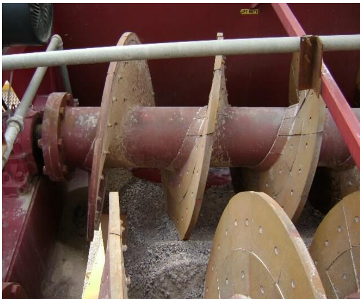
Figura 2-7: Lavado del árido con los tornillos lavadores.
