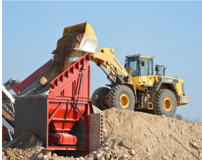
Figura 2-5: Retroexcavadora vaciando el material en la tolva.
