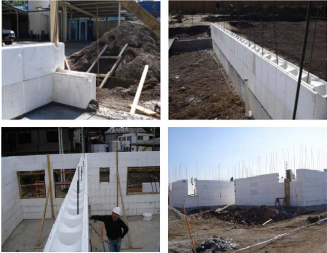
Figura 2-3 Moldaje ICF, Montaje en Terreno
