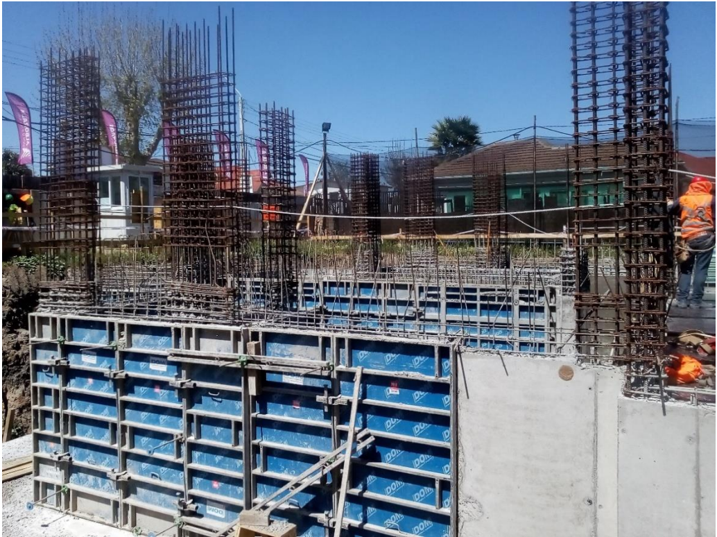
Figura 2-7. Colocación moldajes con alzaprimas
