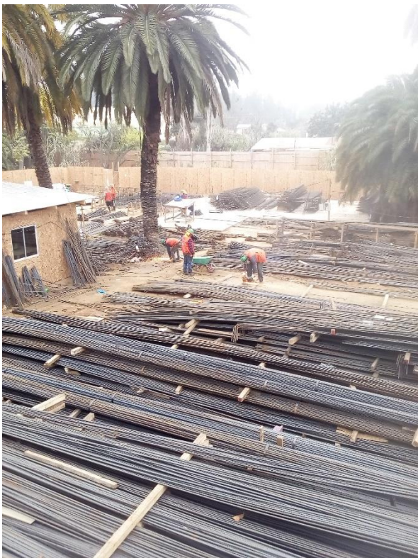
Figura 2-2. Acopio de material (barras de fierro
