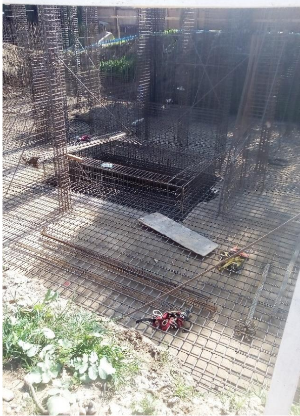
Figura 2-3. Colocación de enfierradura
