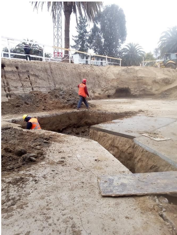
Etapa Obra Gruesa. – Excavación ascensores 1,35 aprox. Emplantillado 10 cm. Tipo de hormigón 085/40/06
