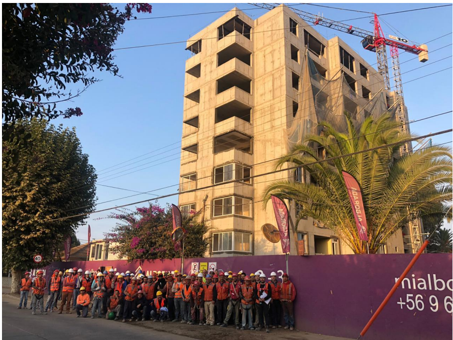
Figura 1-7. Edificio Barrio Norte
