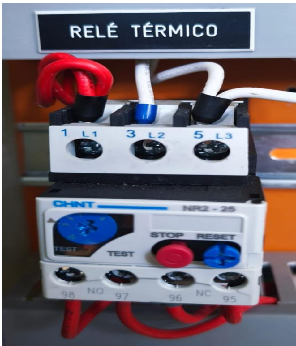
Figura 3-66 Relé Térmico
