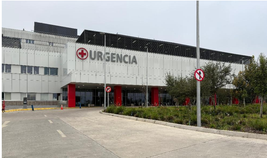
Imagen 1-5: Fotografía, entrada de Urgencias
