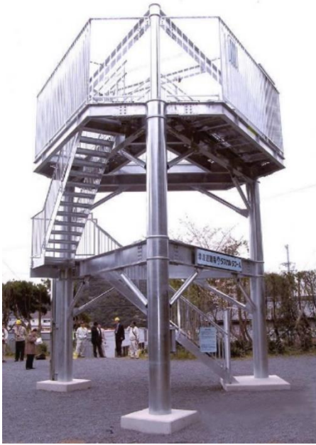
Foto de una estructura de evacuación vertical en Japón que se desarrolló como una opción de evacuación vertical sencilla y económica.
