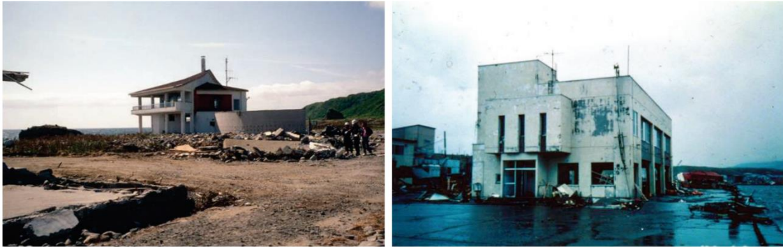
2 estructuras de hormigón armado que sobrevivieron al tsunami de Okushiri de 1993. Ambos son estructuras de hormigón armado de dos pisos, y ambas fueron inundadas por al menos 3 metros de agua: vista house en Cabo Inaho (izquierda); y mercado de pescado en Aonae (derecha) (foto cortesía de N. Shuto).
