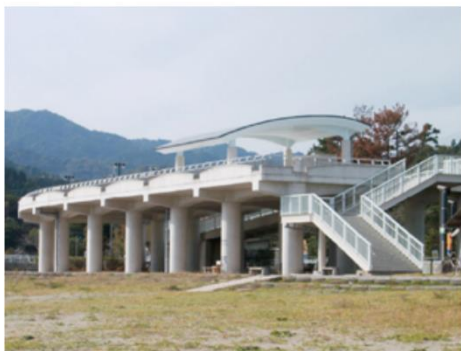
Figura 33. Torre para evacuación vertical. Fuente: FEMA, 2008.
