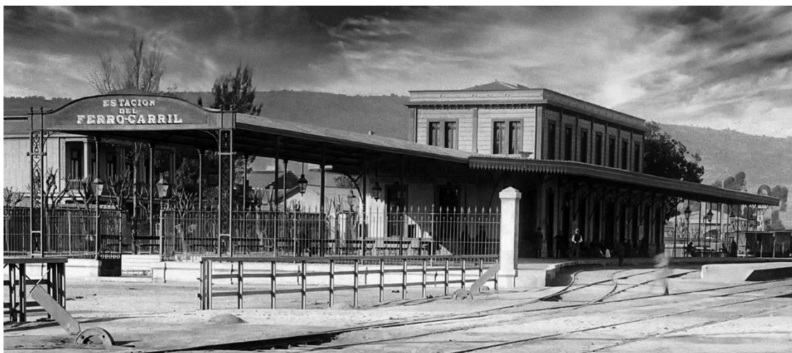
Figura 5 Fotografía Estación de trenes de Viña del Mar, año 1896. Fuente: https://twitter.com/AlbertoSironvalle . 2022.
