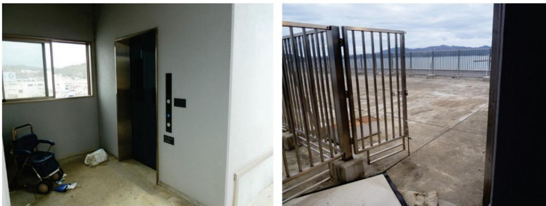
Ascensor exterior y escalera de acceso a gran zona de evacuación en tejado protegida por 2 metros de altura. Valla de protección reforzada en el edificio de evacuación del tsunami en Minamisanriku, Japón (fotos cortesía de I. Robertson y ASCE, de Chock, et al., 2013b).
