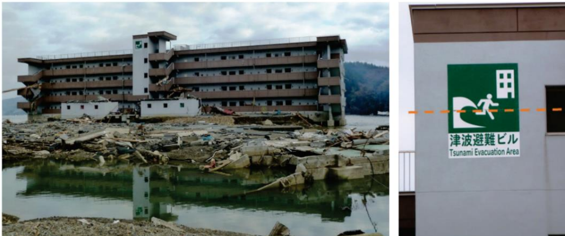
Edificio designado para evacuación de tsunami en Minamisanriku, Japón, y rastros del tsunami nivel de inundación en los carteles de evacuación, tsunami de Tohoku de 2011 (fotos cortesía de I. Robertson y ASCE, de Chock, et al., 2013b).
