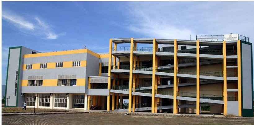
Edificio del Centro de Investigación de Tsunami y Mitigación de Desastres en Banda Aceh, Indonesia. La construcción funciona como refugio contra tsunami para las áreas circundantes, donde la mayoría de los hogares está construido al nivel del mar. Fuente: Hawai'i Tsunami Education Curriculum: Kai E'e.
