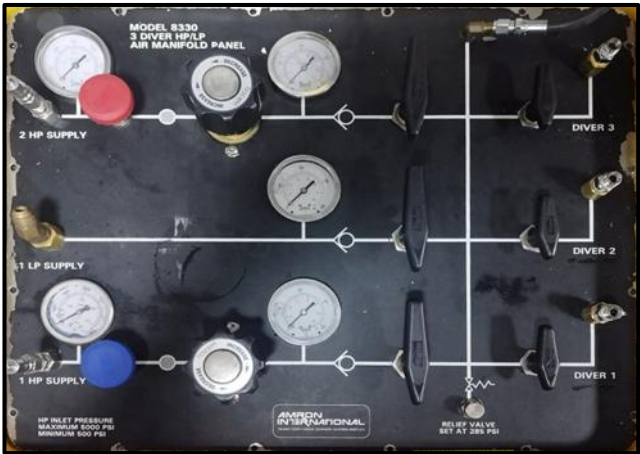
Figura 2-1 Vista Frontal del Panel Inferior Fuente: Partida de Salvataje Talcahuano
