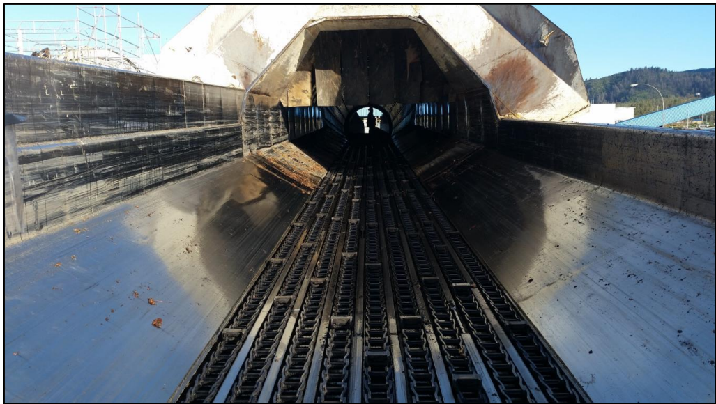
Figura 1-5. Vista interior, sistema de alimentación Power Feed. Acá se pueden apreciar las 9 cadenas con zapata encargadas de transportar los rollizos en bruto de Pino radiata mediante un transportador de tambor hacia el proceso de descortezado y astillado.
