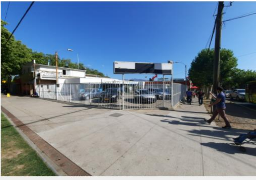
Figura 1-2. Vista Exterior del local.
