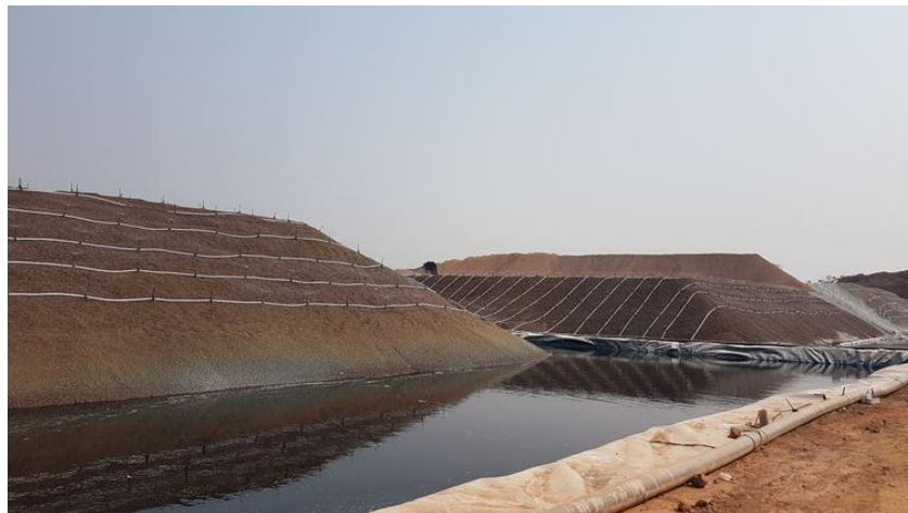
Figura 7: Pila de lixiviación instalada sobre carpeta de geomembrana. Fuente: Agua Royal Spring.
