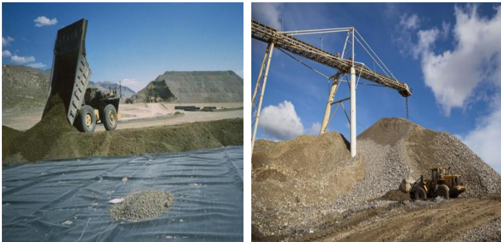
Figura 5: Formación de una pila de lixiviación con mineral de cobre previamente chancado. A la izquierda el material es acopiado por camiones. A la derecha el material se acopia por correa transportadora. Fuente: Alan J. Breitenbach SME.
