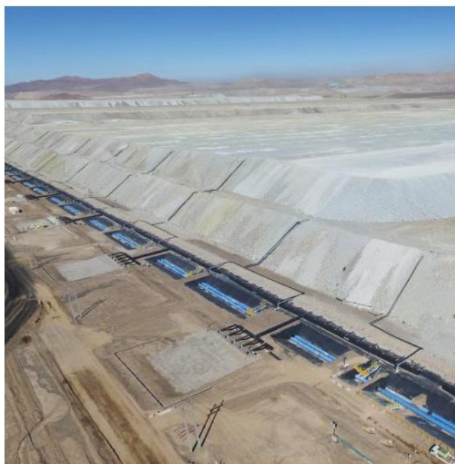
Figura 2: Vista aérea de una pila de lixiviación. Fuente: AG Solutions
