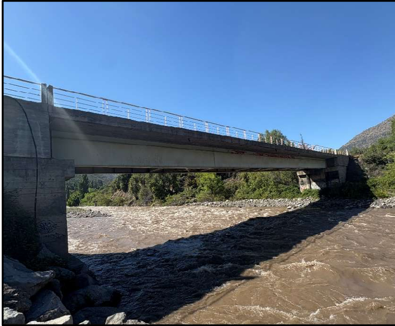
Figura 2-3 Vista general poniente Puente El Toyo.
