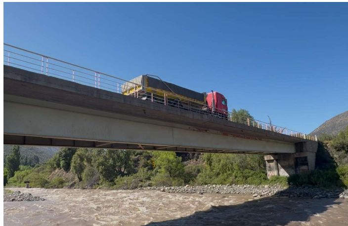
Figura 6-7 Tracto camión con batea circulando por puente El Toyo.
