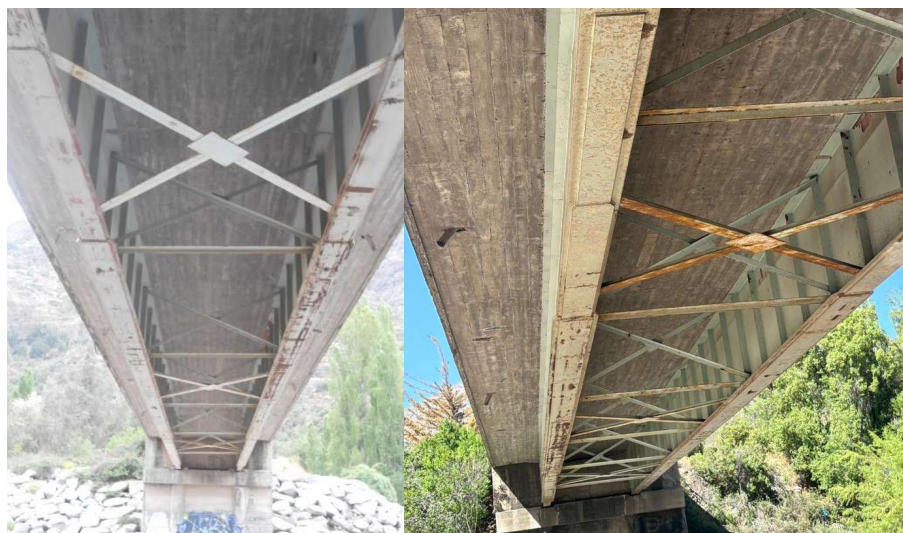
Figura 6-13 Imágenes al inferior de vigas y atiesadores del puente.
