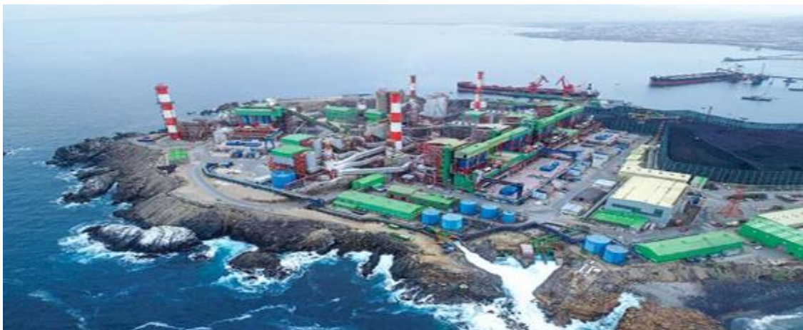
Figura 55. Ubicación e infraestructura de la central Guacolda.
