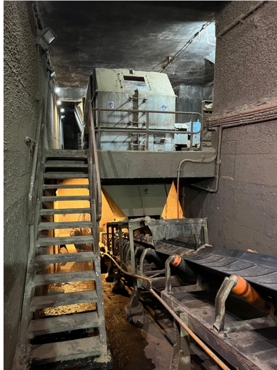
Figura 1- 6: traspaso reclaimer a cintas transportadoras
