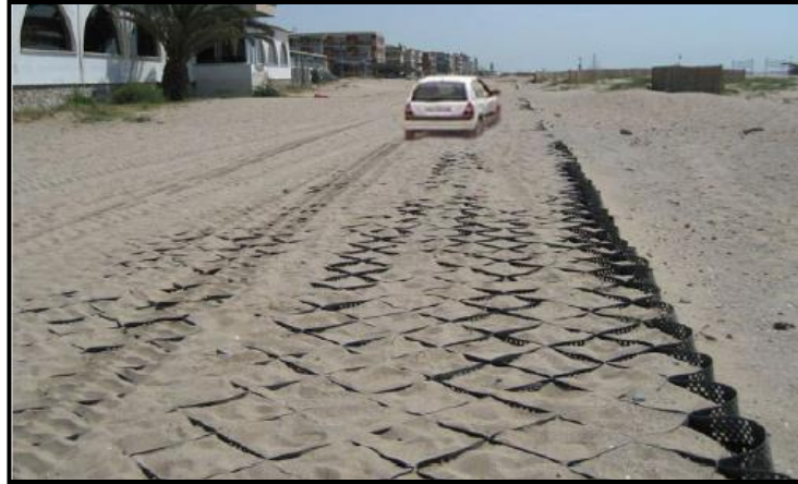
Figura 2-3 Geocelda utilizada en camino de arena. [9]
