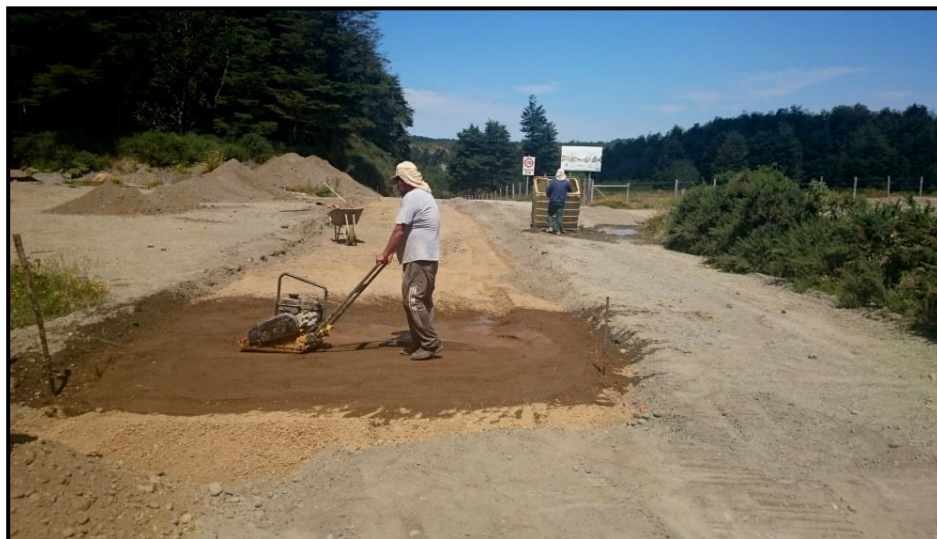
Figura 4-10 Colocación de Subbase [29]
