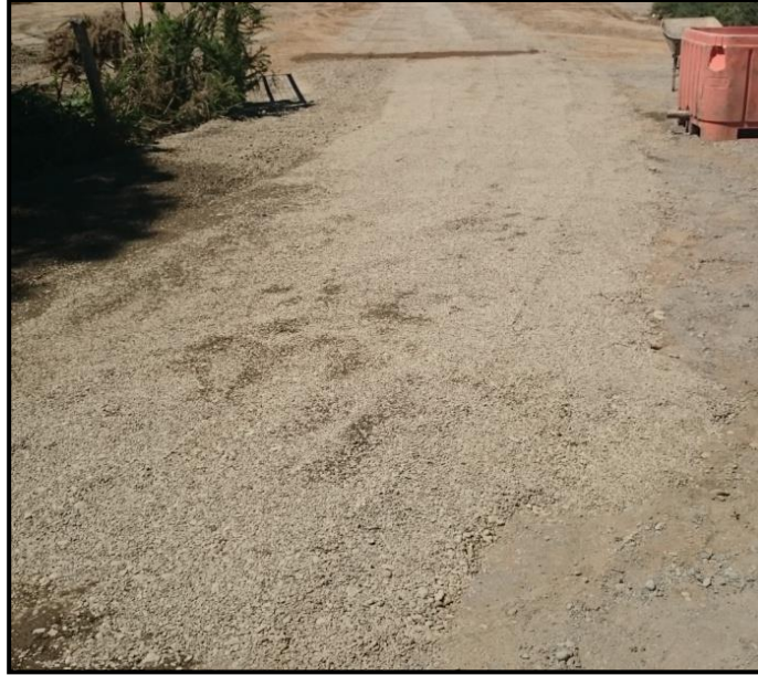
Figura 5-6 Pista de Prueba Construida sin Geocelda [29]
