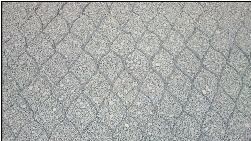
Figura 5-11 Pista con geocelda de espesor 100[mm] después de una semana de tránsito [29]
