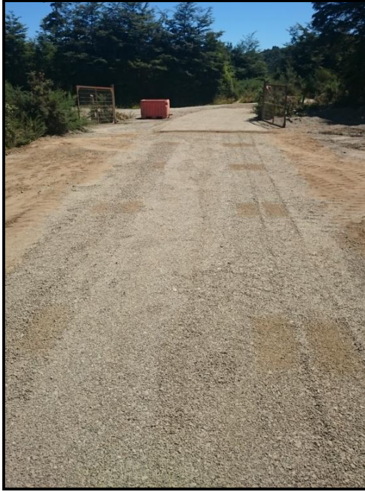
Figura 5-4 Pista de Prueba Construida con Geocelda de Espesor 100 [mm] [29]
