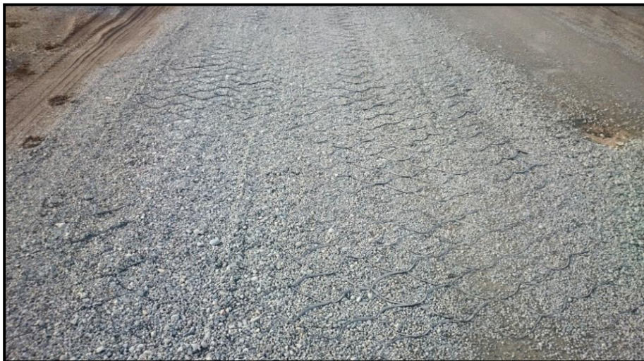
Figura 5-13 Pista con geocelda de 100[mm] después de 6 semanas de tránsito [29]
