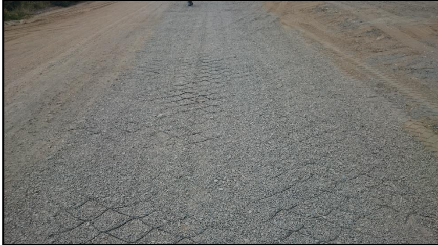
Figura 5-10 Pista con geocelda de espesor 75[mm] después de una semana de tránsito [29]
