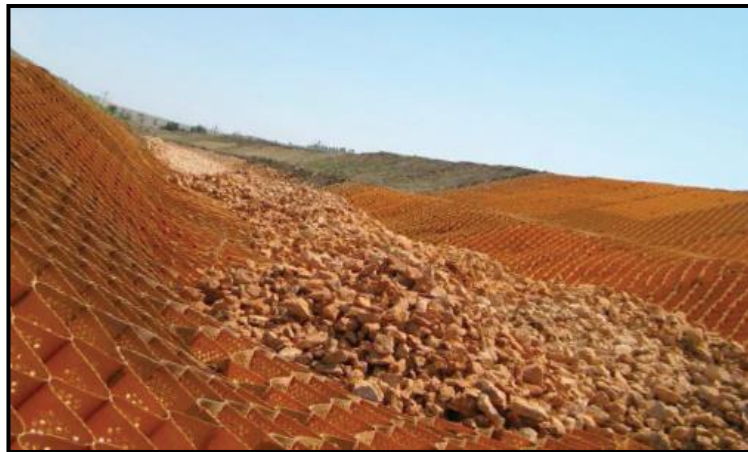
Figura 2-2 Geocelda utilizada para protección de Canales y de Riberas de ríos. [9]
