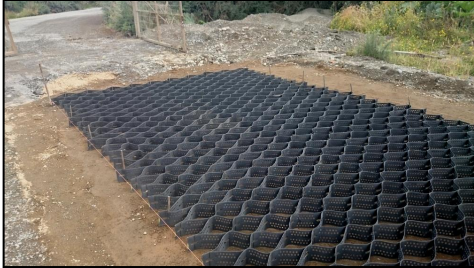
Figura 4-12 Geocelda Extendida Pistas de Prueba [29]
