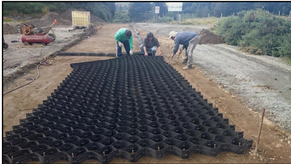
Figura 4-11 Proceso de extensión de la Geocelda de Pistas de Prueba [29]
