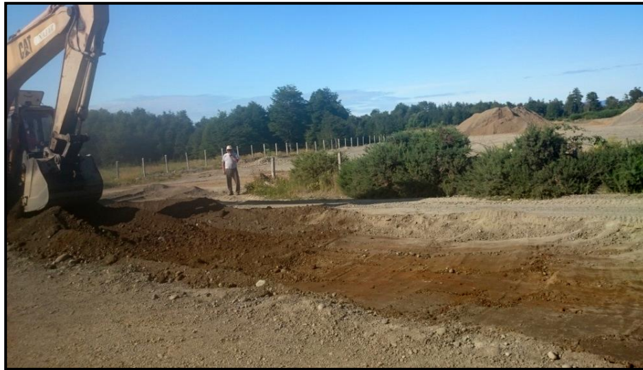
Figura 4-9 Remoción de escombros [29]
