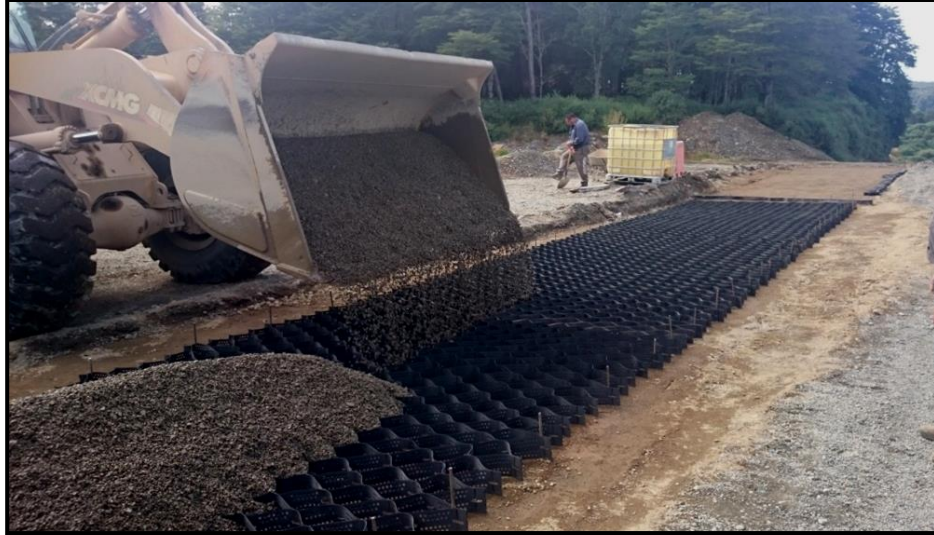
Figura 4-16 Llenado de Geocelda con gravilla mediante pala mecánica en Pistas de Prueba [29]
