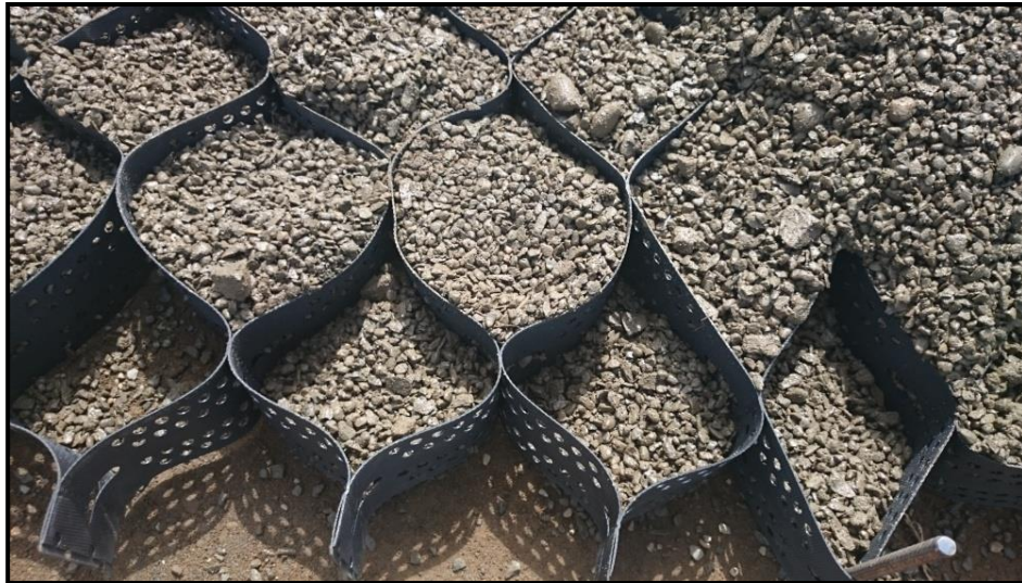
Figura 4-17 Geocelda en proceso de llenado [29]
