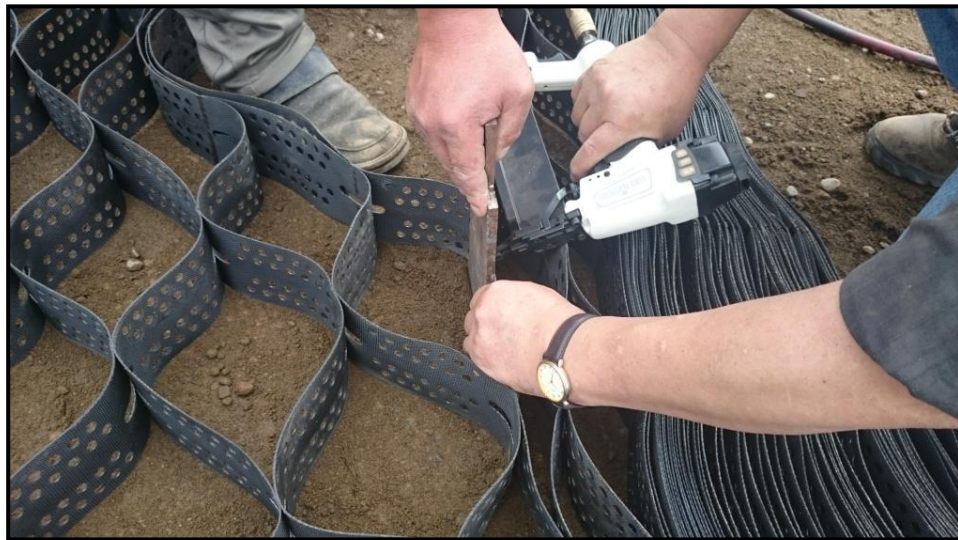
Figura 4-13 Unión de Geoceldas [29]
