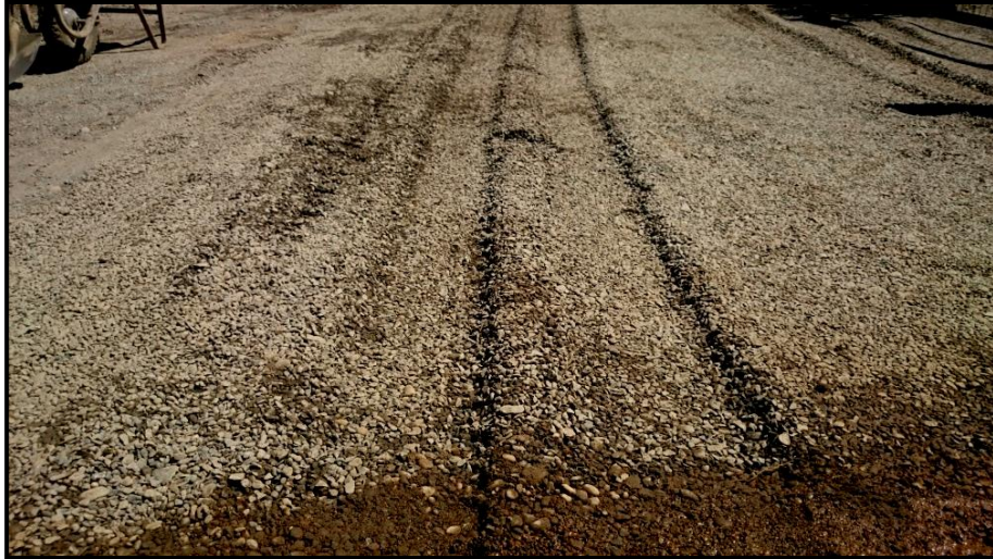
Figura 5-12 Pista de prueba sin refuerzo de geocelda [29]
