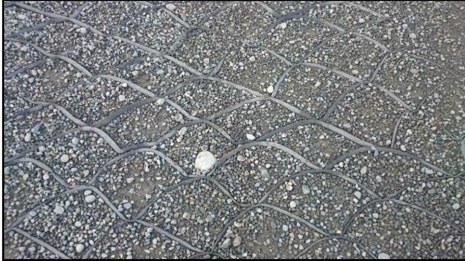
Figura 5-14 Pista con geocelda de 75 [mm] después de 6 semanas de tránsito [29]
