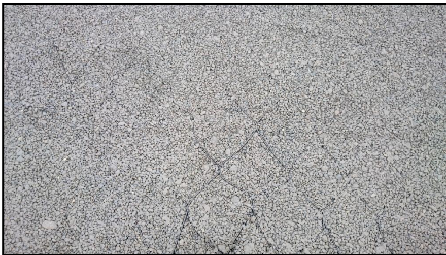
Figura 5-5 Pista de Prueba Construida con Geocelda de Espesor 75 [mm] [29]
