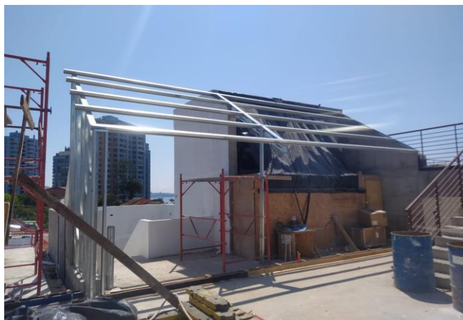
Figura 2-6. Estructura de salida a la terraza
