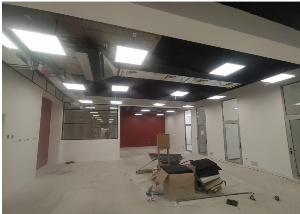
Figura 2-1. Instalación cielo espuma
