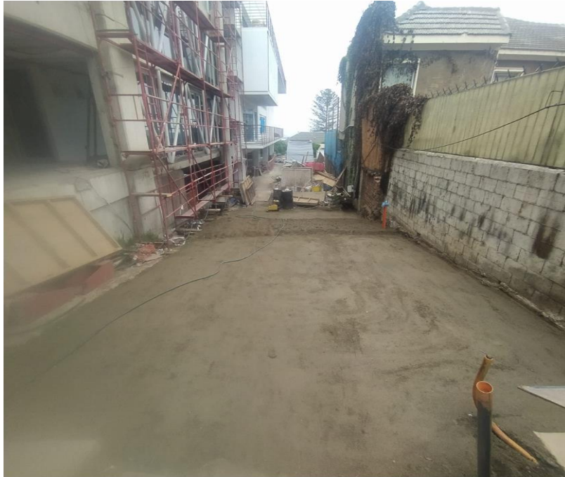
Figura 2-5. Compactación de terreno (zona malla a tierra)
