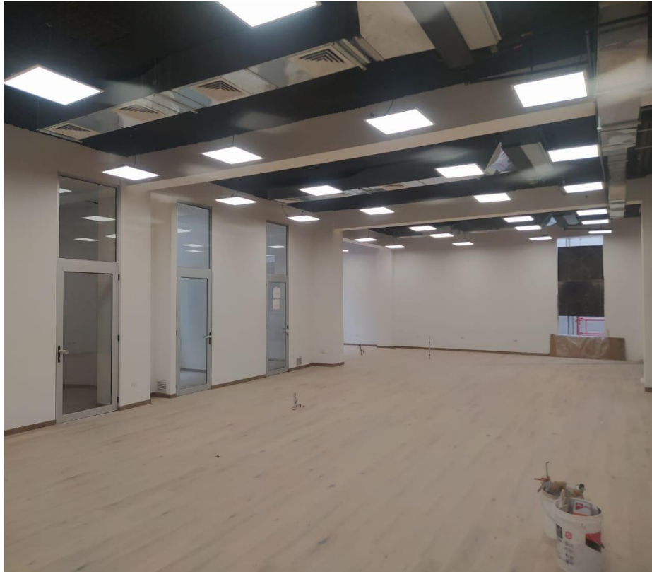
Figura 2-2. Colocación piso flotante
