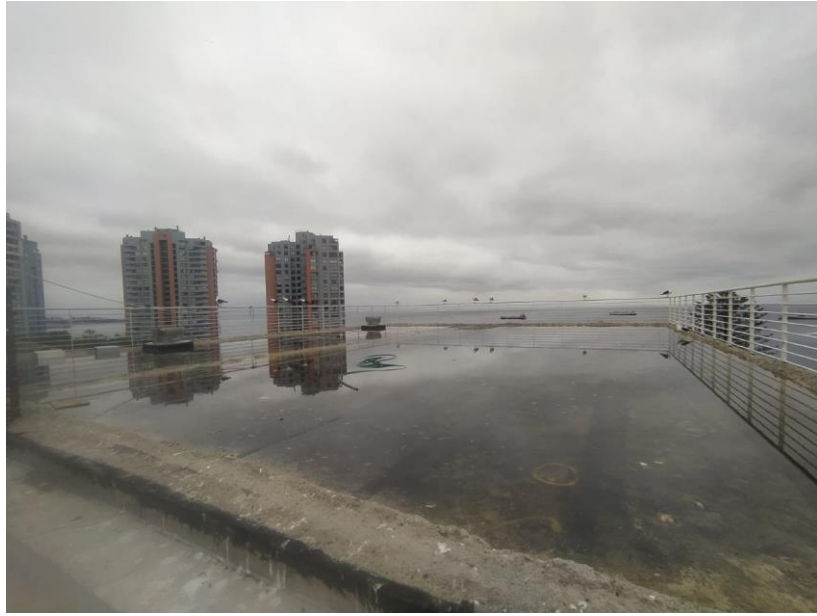
Figura 2.3. Prueba de impermeabilización
