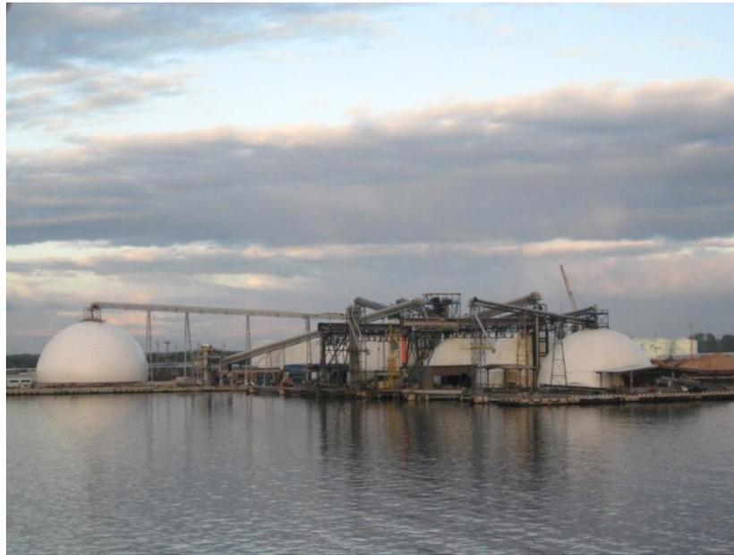
Figura 2.9: Stockpiles cónicos de presión negativa de carbón y cal Riga, Letonia.
