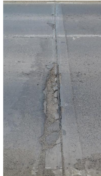
Figura 4-5 Junta de expansión rota
