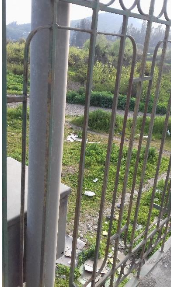
Figura 4-3 Baranda de acero
