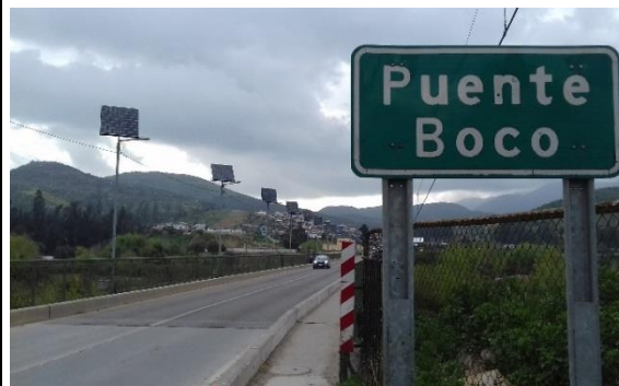
Figura 4-2 Vista general puente Boco
