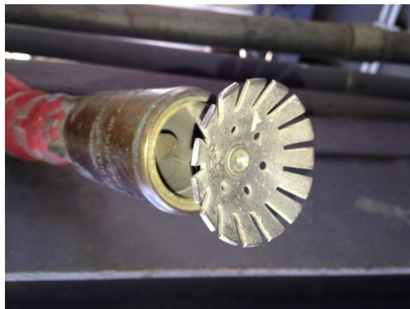
Figura 7 Imagen de Sprinkler en mesas de carga
