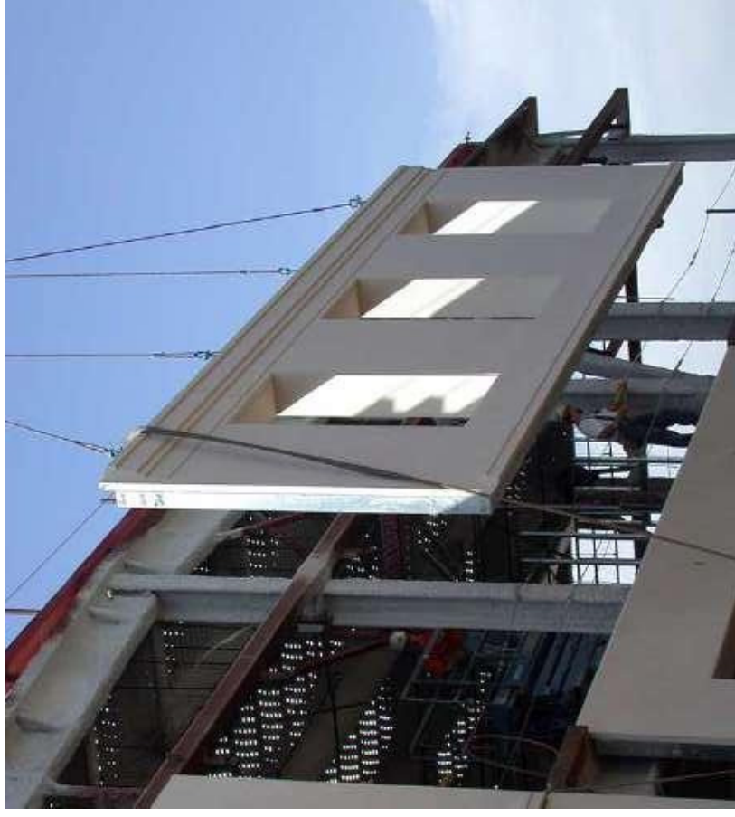
Figura 6. Hall Acceso Aeródromo Balnaceda Fuente: Iglésis Arquitectos (2022).
