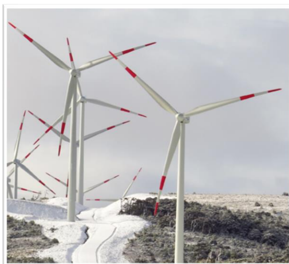
Figura 3-10: Señalamiento e iluminación de las turbinas.
