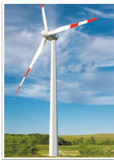
Figura 2-3: Turbina eólica tipo HAWT con 3 aspas.
