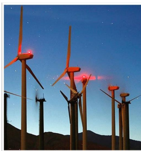
Figura 3-10: Señalamiento e iluminación de las turbinas.
