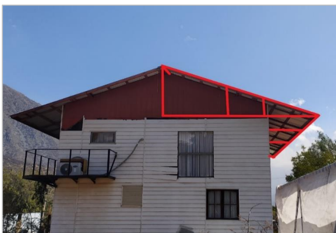
Figura 31: Referencia de la instalación de la estructura en el módulo 2.
