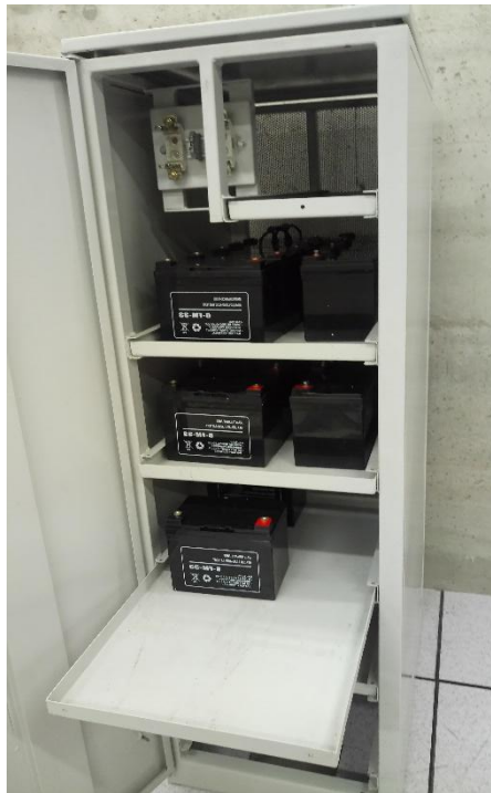
Figura 2-4. Banco de baterías externo
