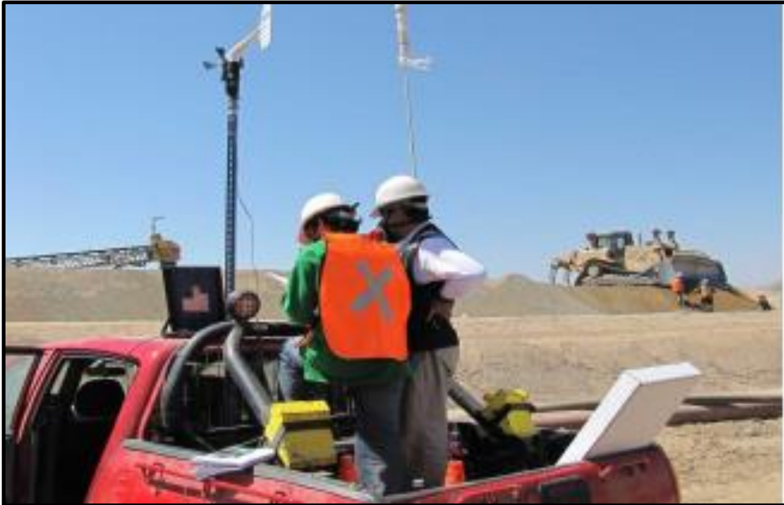
Ilustración 13 Descarga de material en pila y operación Bulldozer de Dayton
