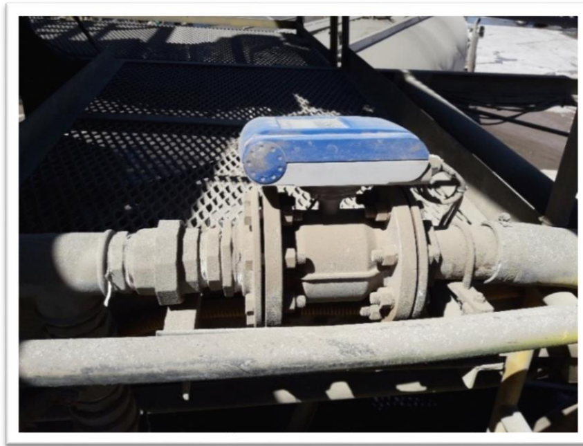
Imagen 3-8; Flujómetro de agua.
