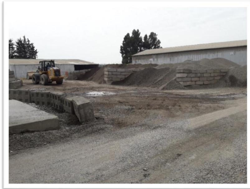
Imagen 3-9; Acopios áridos (vista frontal).
