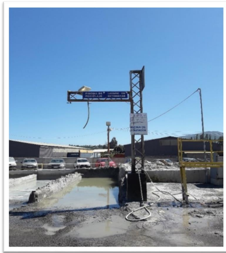
Imagen B-24; Estructura pilón lavado camiones.
