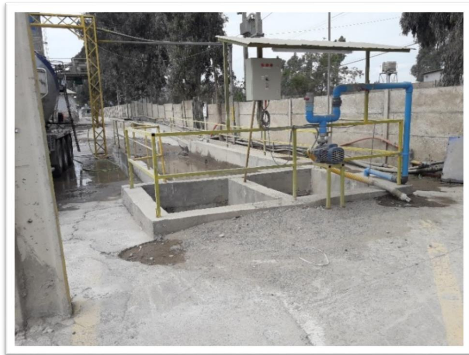
Imagen B-26; Piscina decantadora n° 1.
