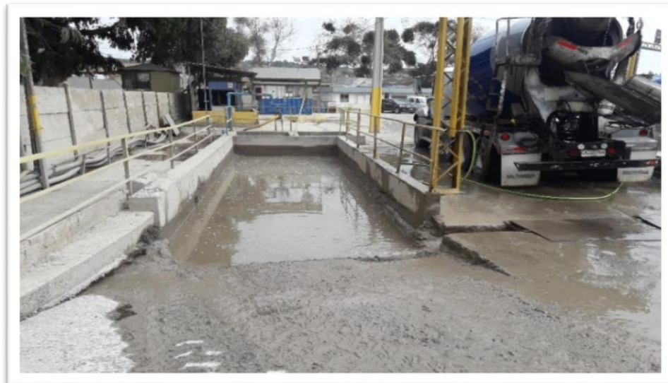
Imagen B-25; Piscina decantadora n° 1.
