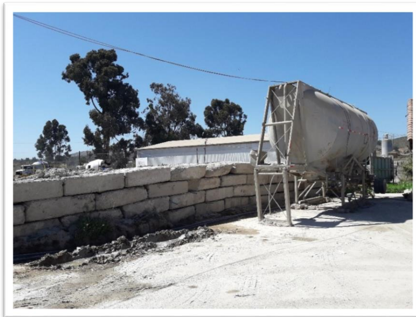
Imagen B-22; Silo horizontal almacenamiento de agua.
