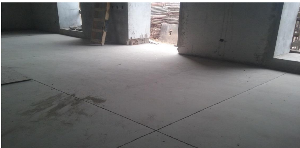
Fuente: Constructora Gómez Recabarren Ltda.
