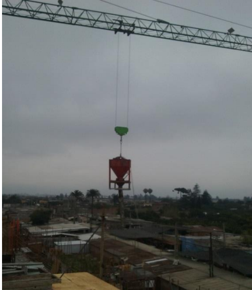
Fuente: Constructora Gómez Recabarren Ltda.
