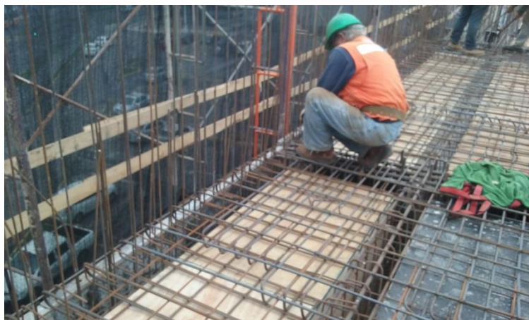
Fuente: Constructora Gómez Recabarren Ltda.
