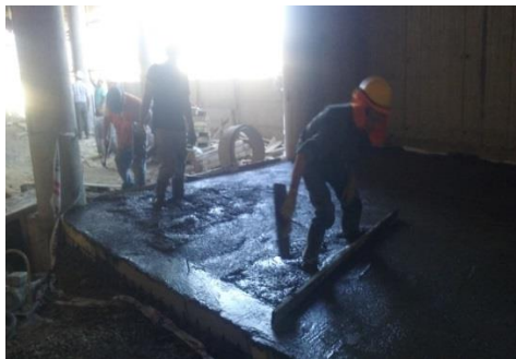
Fuente: Constructora Gómez Recabarren Ltda.
