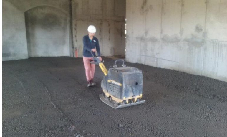
Fuente: Constructora Gómez Recabarren Ltda.
