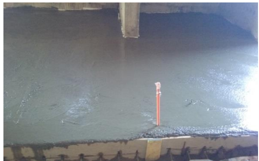
Fuente: Constructora Gómez Recabarren Ltda.
