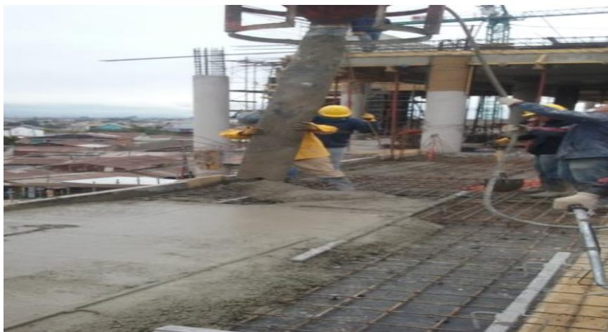
Fuente: Constructora Gómez Recabarren Ltda.
