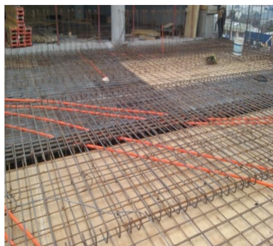
Fuente: Constructora Gómez Recabarren Ltda.
