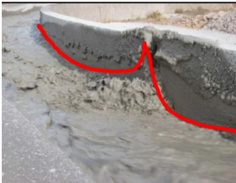
Figura 3-11: Desborde por ondas cruzadas en Curvas
