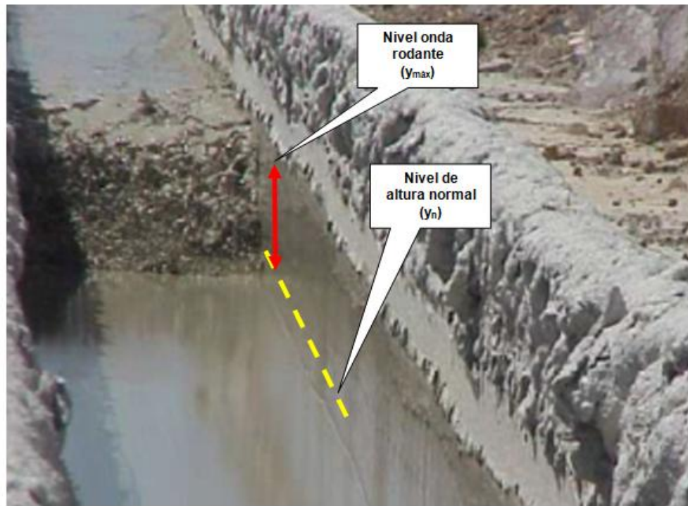
Figura 3-6: Fotografía de onda rodante en canaleta de hormigón
