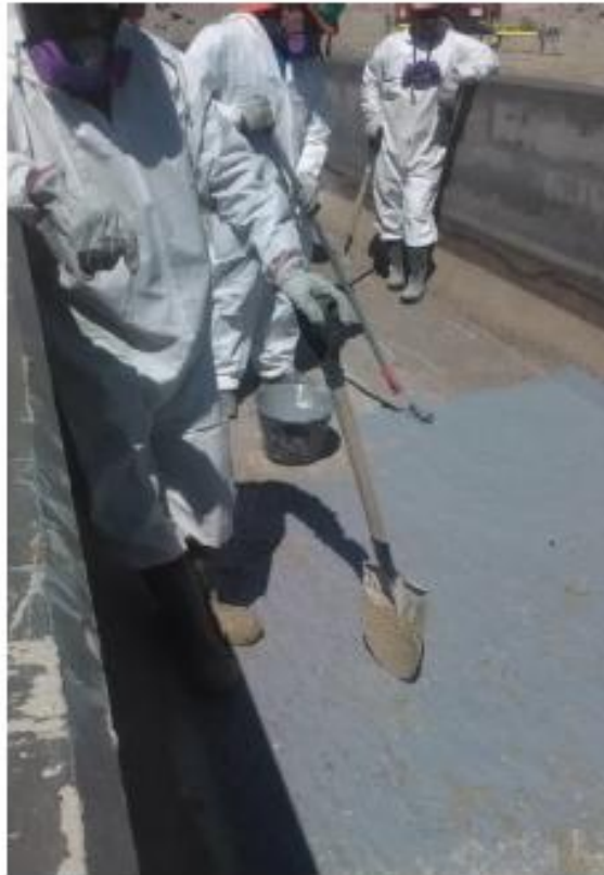
Figura 7-9: Aplicación de Puente de Adherencia Sikadur 32
