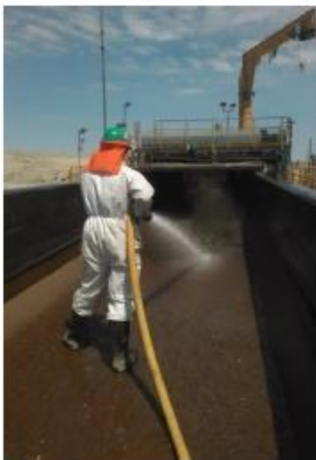
Figura 7-5: Limpieza Interior Canaleta con Agua a Presión
