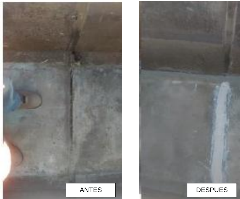
Figura 7-12: Junta de Construcción, antes y después de la aplicación del sello
