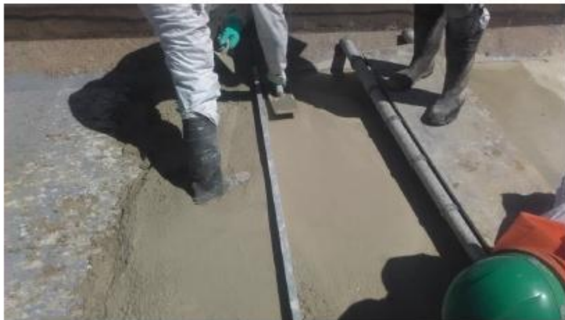
Figura 7-10: Aplicación del Mortero de Reparación
