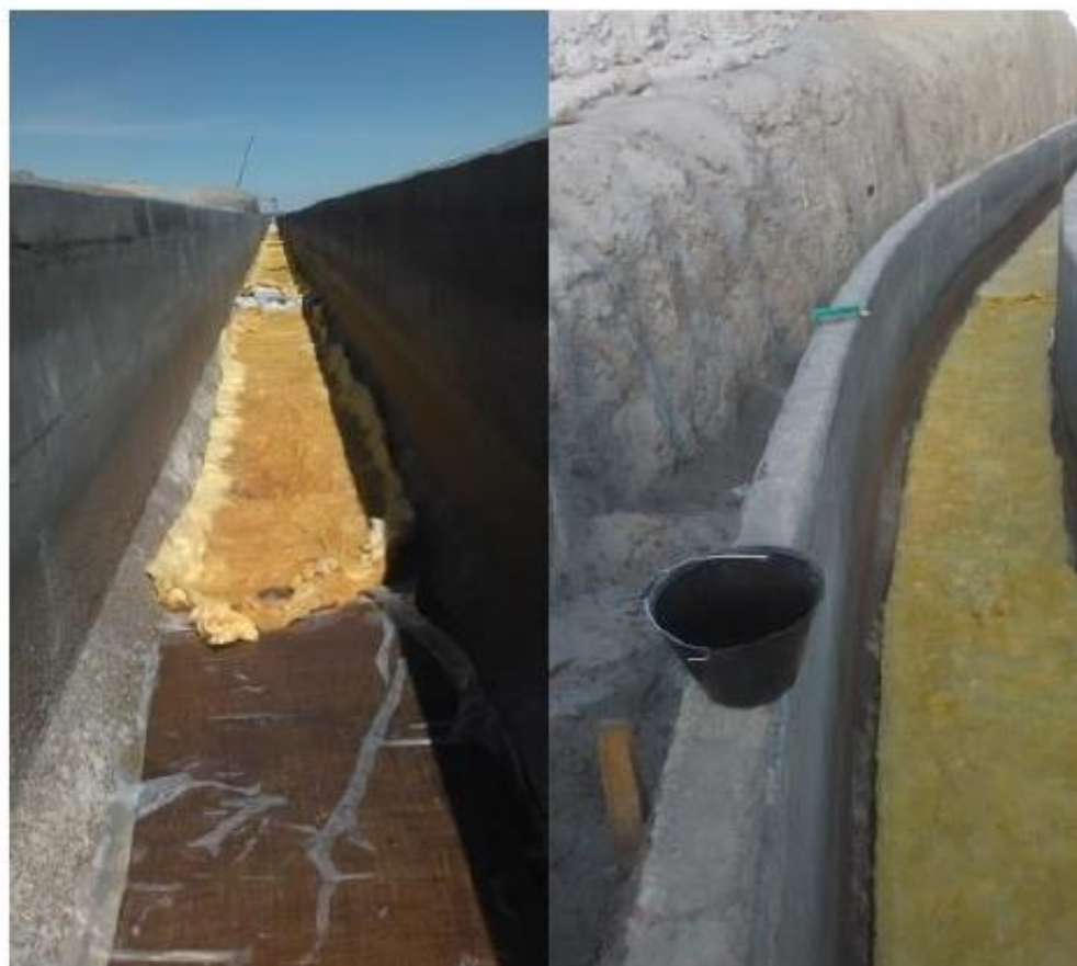
Figura 7-11: Canaleta cubierta con Arpillera, Polietileno y Lana Mineral
