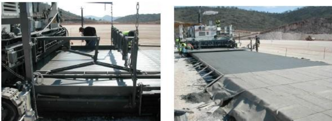
Figura 2.4.: Aplicación de fibra en pavimentos portuarios (Aplicaciones del HRF, Ana Blanco 2015).
