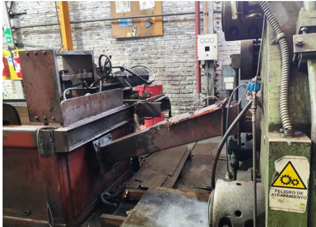
Figura 3-2: cámara de nitrógeno del wax-tank
