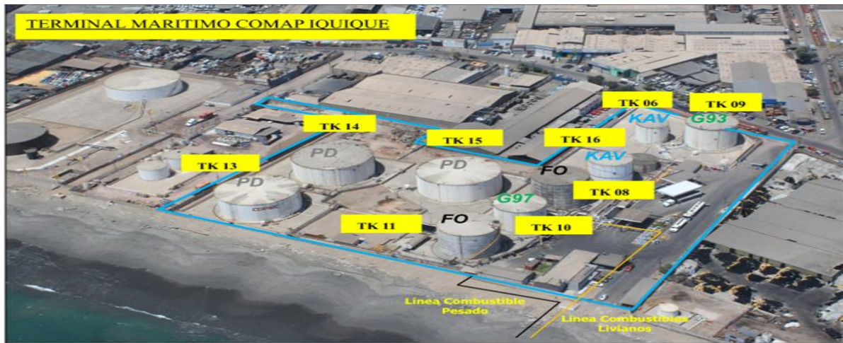
Figura 6. Vista aérea de patio de tanques en un terminal marítimo [23]. Fuente: COPEC S.A. (2023).
