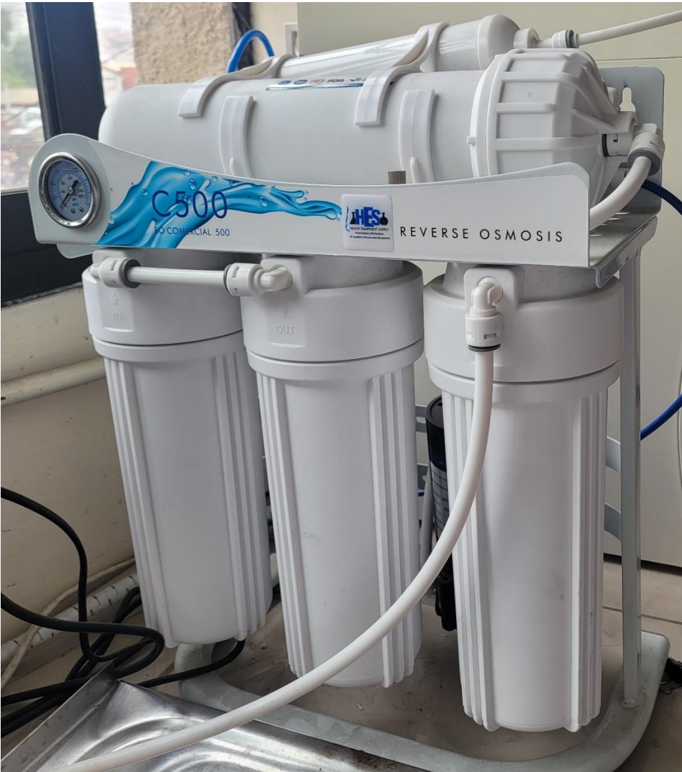
Figura 2-8: Equipo de osmosis inversa
