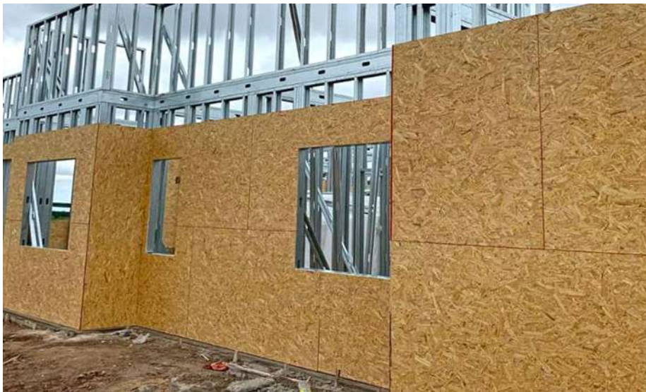
Imagen N° 6: construcción modular con OSB
