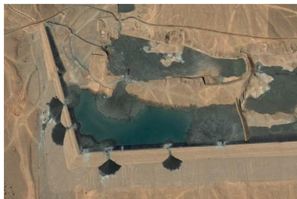
Figura 31. Imagen satelital inicio de operación Tranque Las Cruces, Septiembre 2004. Google Earth
