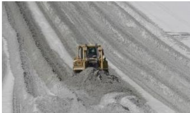
Figura 6. Compactación mecánica. www.tranex.cl
