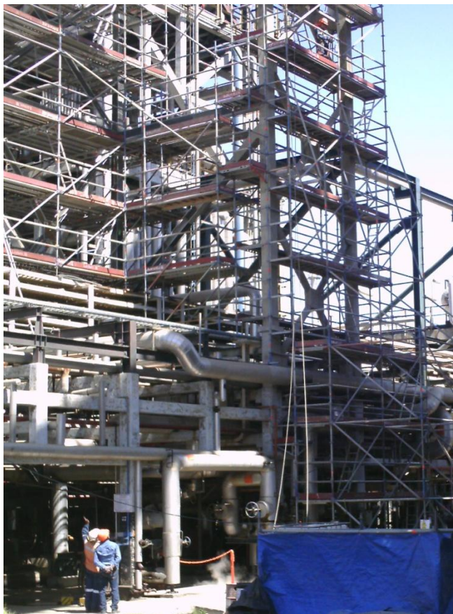
Figura 7.10. Andamios en planta Topping 1.
