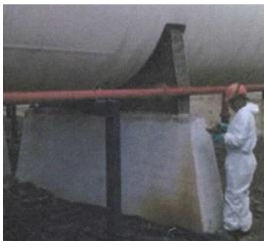
Figura 7.11. Trabajos de ignifugado en planta LPG (ERRES, 2015).
