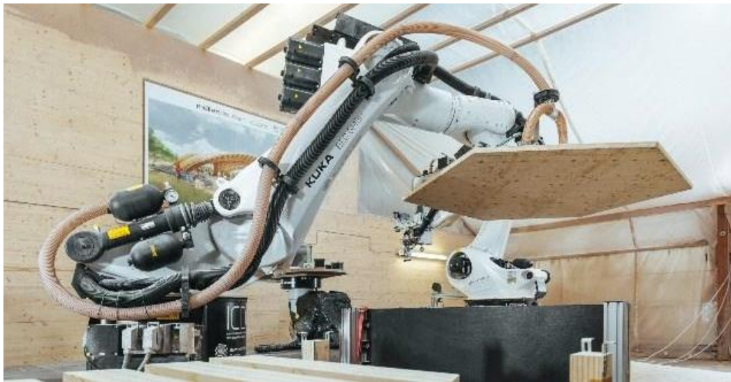
Fig. 19. Montaje de estructura en madera. Landázuri (2022)
