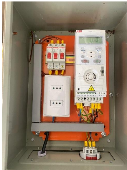
Figura 5: VDF del molino de barras.
