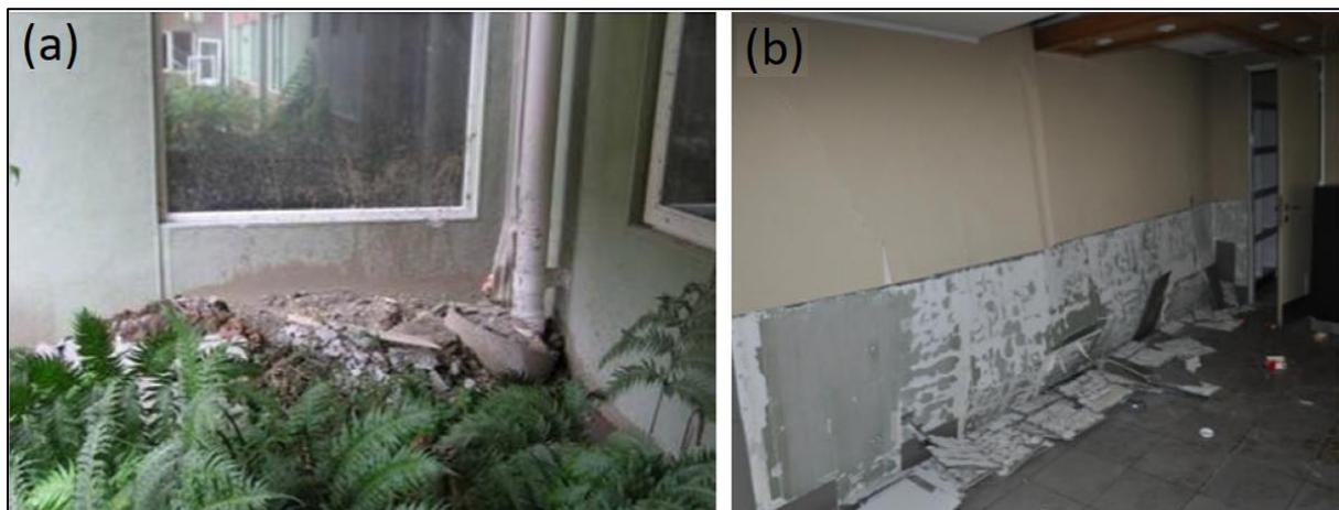
Figura 9. Hospital provincial de Curanilahue (a) evidencia de material eyectado y (b) muro de partición dañado producto de la distorsión del suelo en el ala 1C. (Bray et al., 2012)
