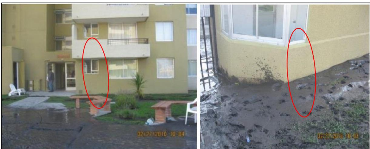
**Figura 7. Evidencia de licuación en el Edificio Riesco, a) evidente inclinación y asentamiento, b) eyección de suelo visible en el muro. (González, 2015)**
