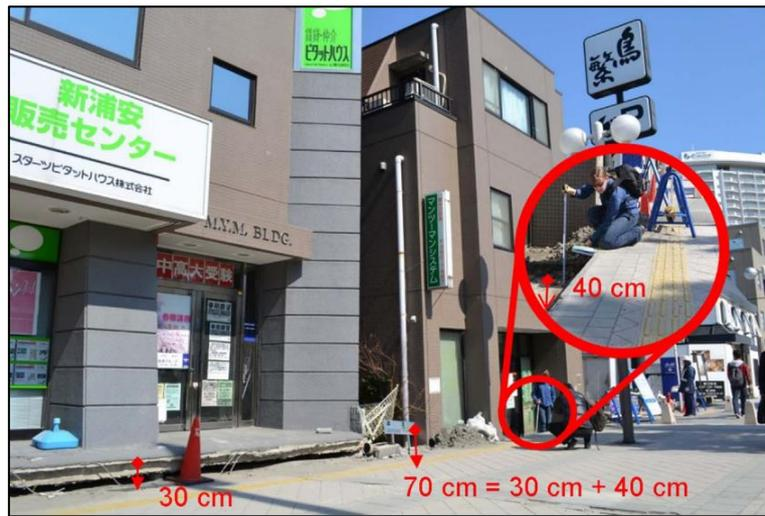
Figura 10. A la izquierda, edificio apoyado sobre pilotes, A la derecha, edificio con fundación superficial.
