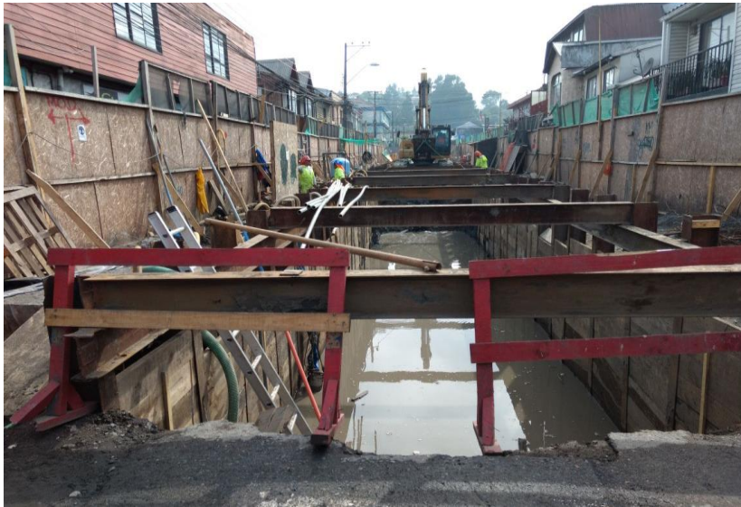
21 FIGURA 4-1 EXCAVACION CAJON
