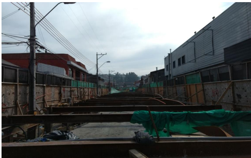
23 FIGURA 4-3 TRAMO DE CAJON HORMIGONADO
