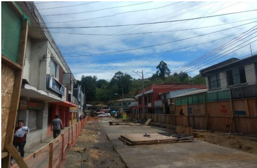
25FIGURA 4-5 RELLENO CONTENCIÓN DEL CAJÓN
