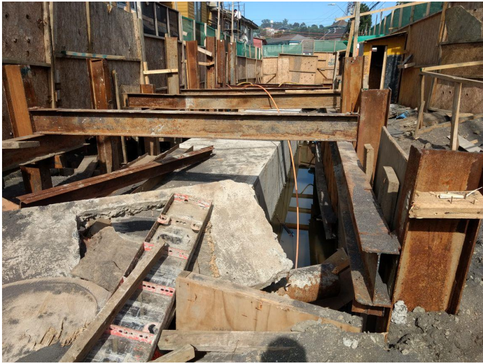
24 FIGURA 4-4 TRAMO CAJON HORMIGONADO
