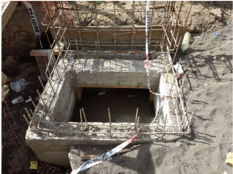
37 FIGURA 4-17 SUMIDERO EN CONSTRUCCIÓN
