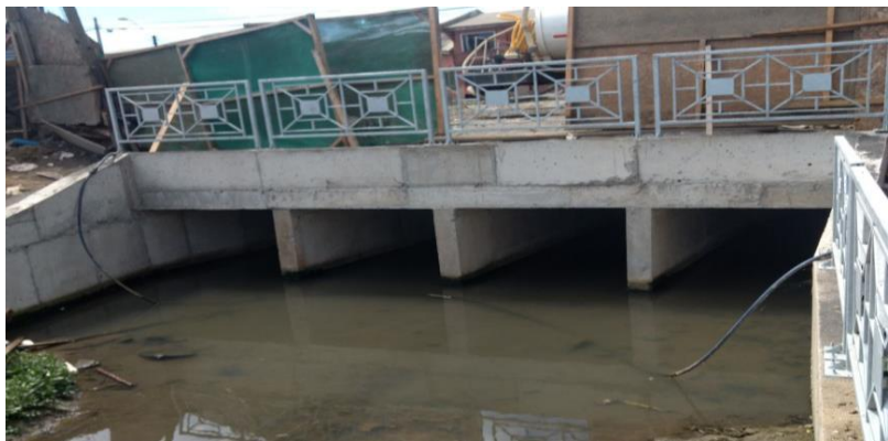
47 FIGURA 4-27 INICIO CANAL ABIERTO (4 CAJONES)
