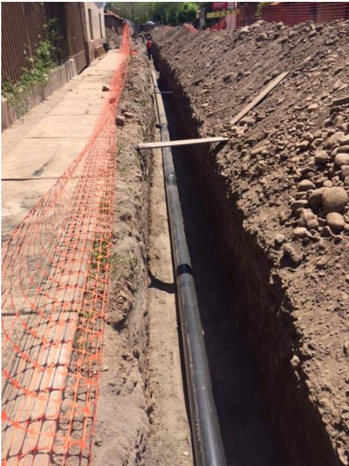
Fuente: Proyecto “Construcción Redes de Alcantarillado Curimón.”
