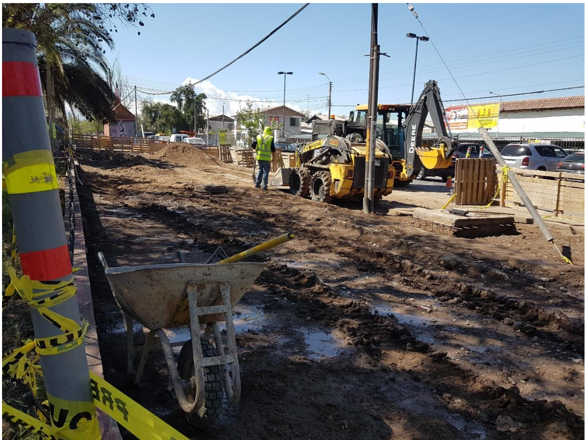
Figura 2-24. Obra Gruesa y Albañilería.
