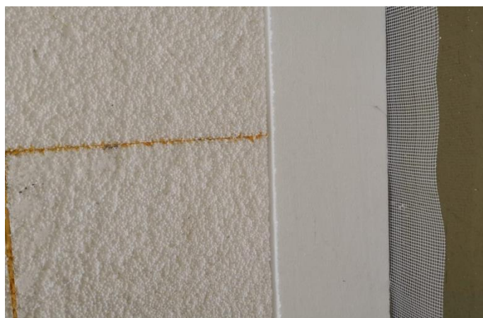
Imagen N°18: Detalle de muro enrasado y aplomado
