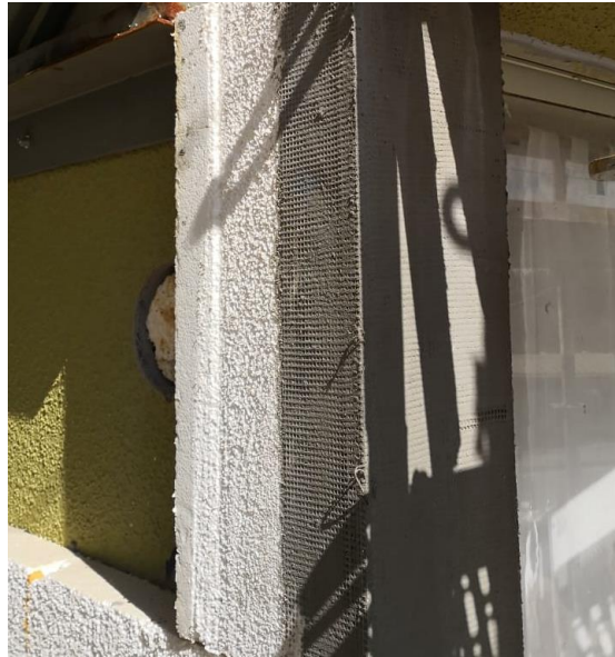
Imagen N°20: Refuerzo en esquina expuesta
