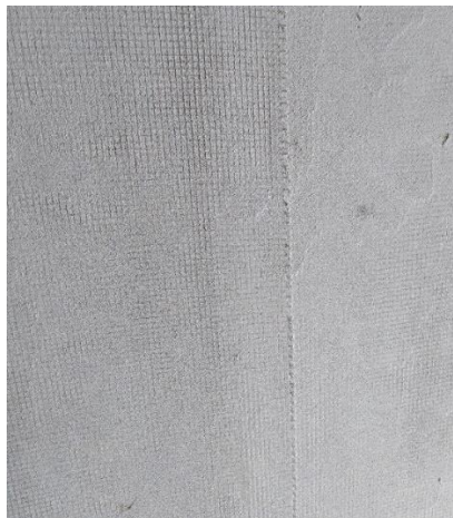
Imagen N°19: Malla de fibra de vidrio embebida en el aislante
