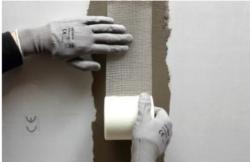
Imagen N°30: Tratamiento de juntas con cinta de fibra de vidrio
