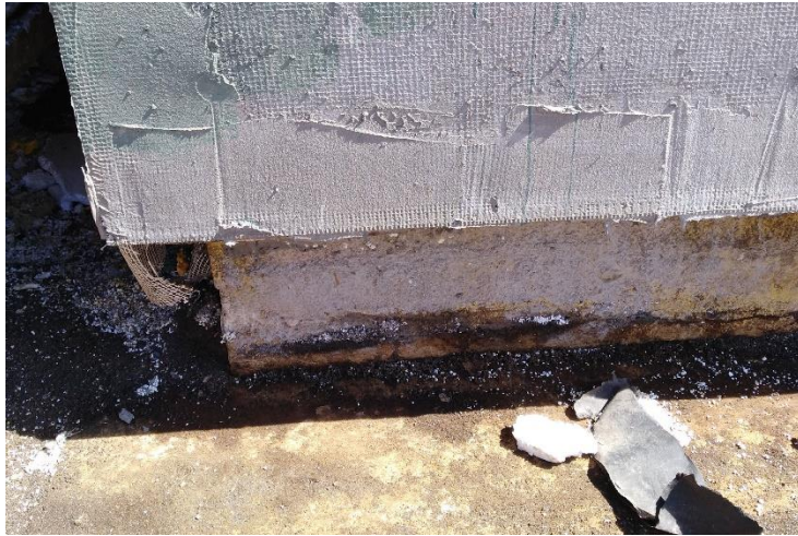
Imagen N°12: Excavación a 10 cm del NPT y encapsulamiento del borde inferior
