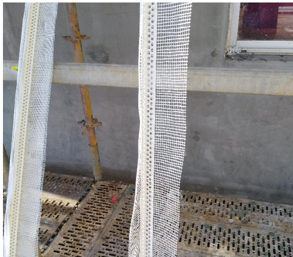
Imagen N°21: Esquinero de PVC con malla de fibra de vidrio
