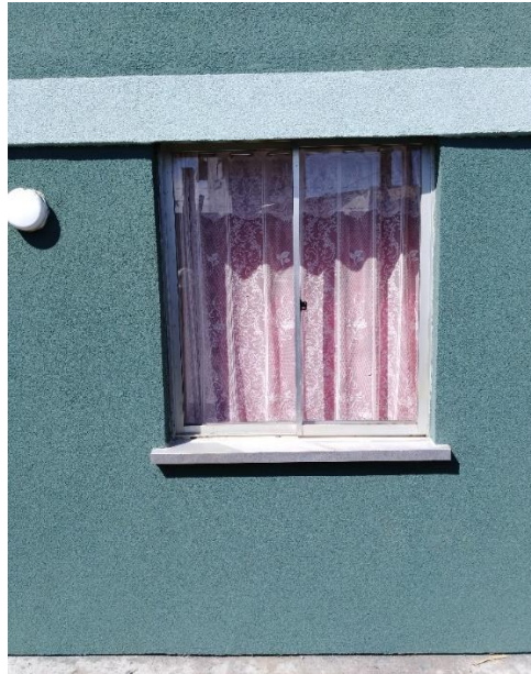
Imagen N°22: Fachada con sistema EIFS terminado
