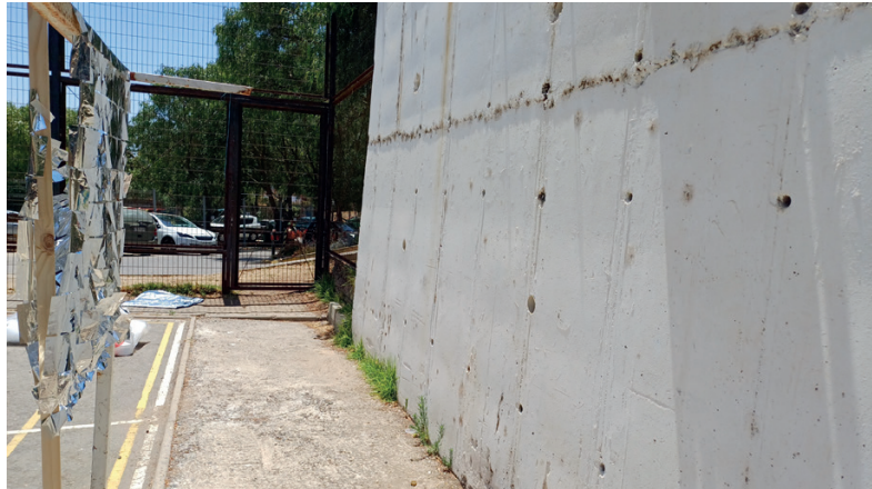
Altura de 0,7 m a 1,8 m 12:50 hrs
