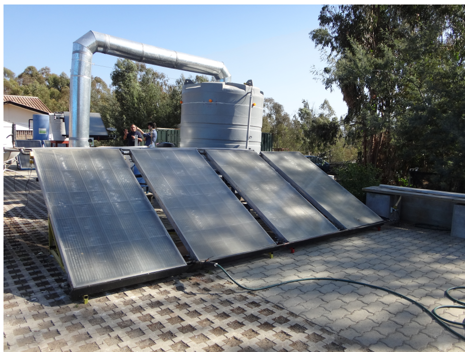
Figura 4.1: Fotografía de la planta de desalinización ubicada en el LER.
