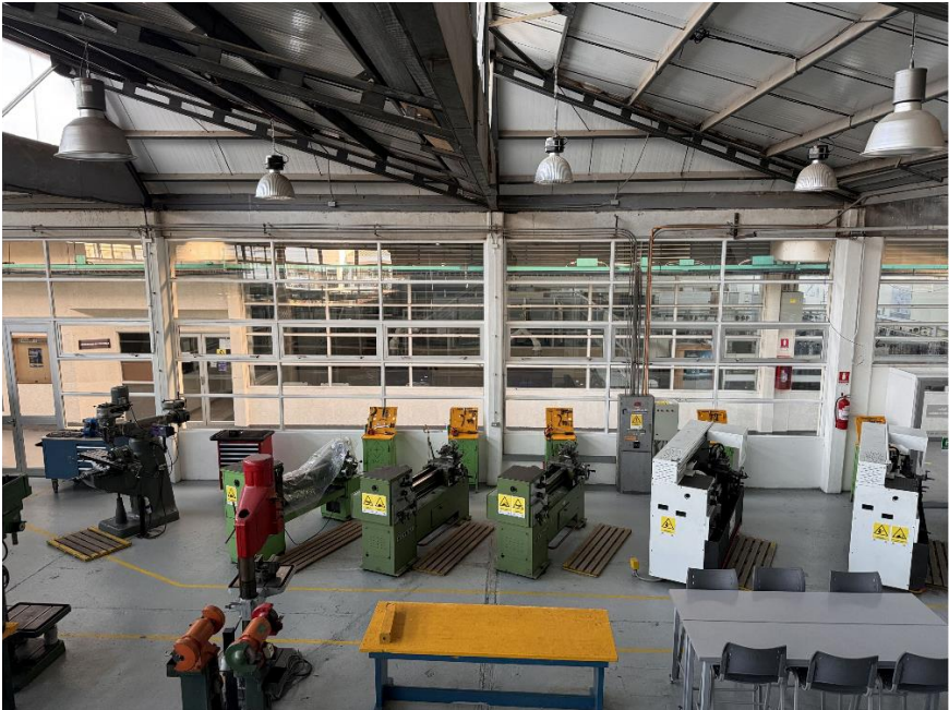
Figura 4.1.2-1: Cielo de taller de mecánica, situación actual. Fuente: Elaboración propia,2024
