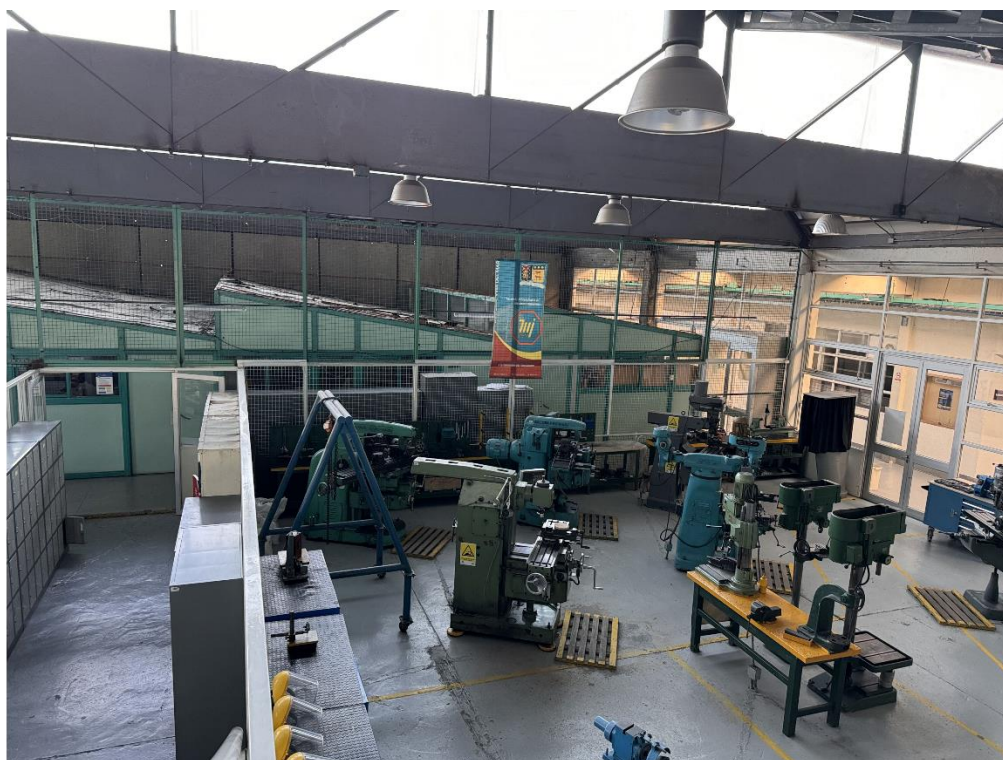
Figura 4.1.2-6: Muro oeste taller de mecánica, situación actual. Fuente: Elaboración propia,2024
