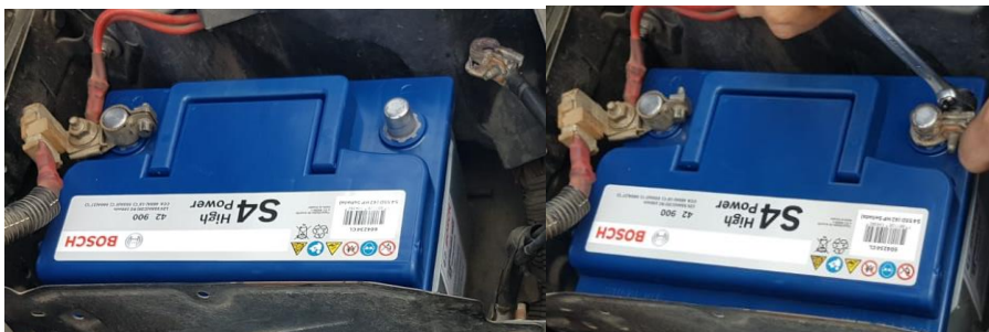
Figura N°59: Conexión de batería nueva (Fuente propia)
