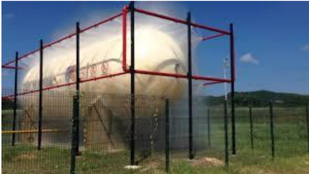
Figura 2-07 Sistema de diluvio
