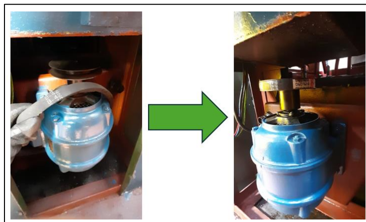
Figura 24-Cambio de correa en sistema de potencia. Unidad oleohidráulica.
