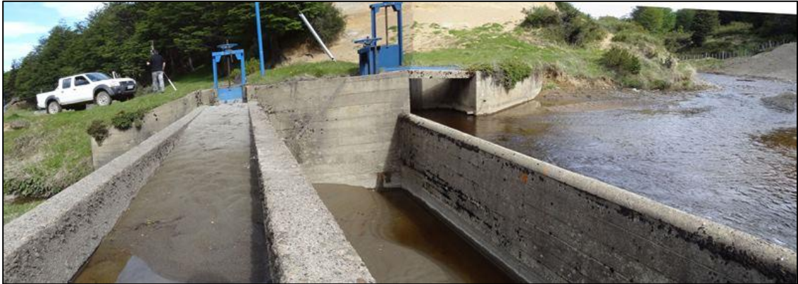
Figura 2.3: Acueducto río Las Minas – Captación Chorrillo Lynch
