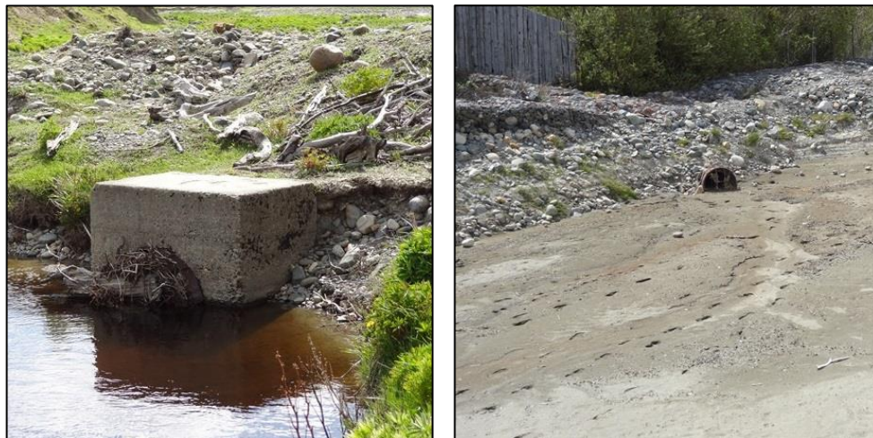
Figura 7.1: Estado de las Captaciones Tres Brazos y Leñadura – Visita a terreno 26/11/15
